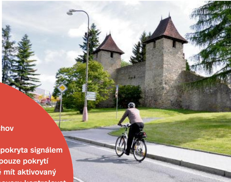
Tachovské staré městské hradby.
