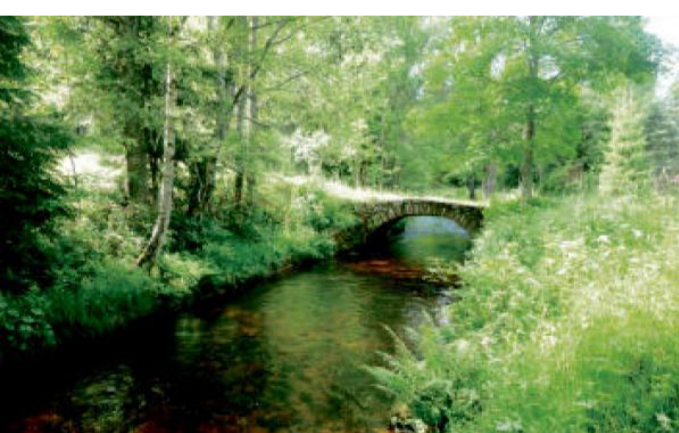
KAMENNÝ mostek na plavebním kanále.
