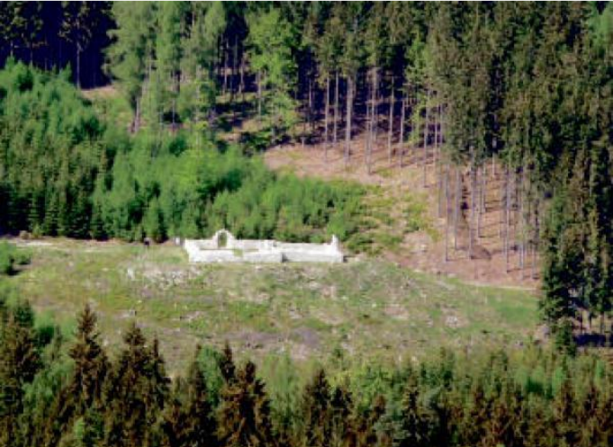
OBNOVENÉ základy kostela sv. Mikuláše z pohledu věže. Foto: Petr Hejl
