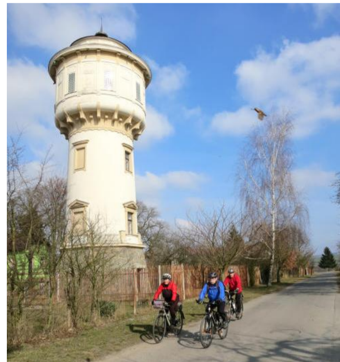
DOBŘANY – vodárenská věž.
