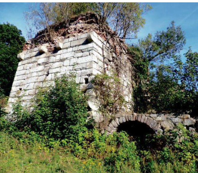
Vysoká pec v Šindelové.
