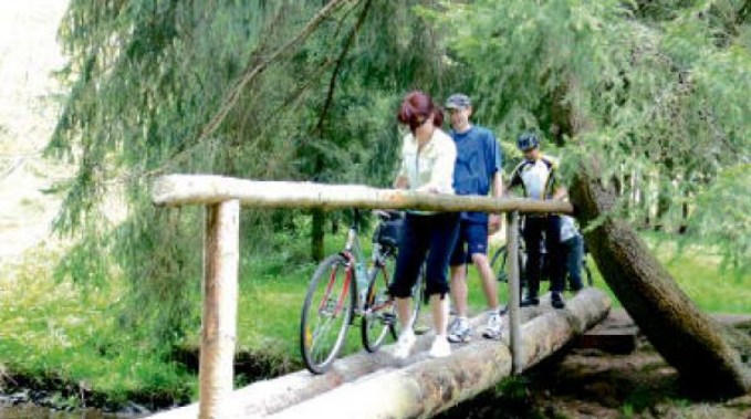
Lávka přes potok pod Gutštejnem.
