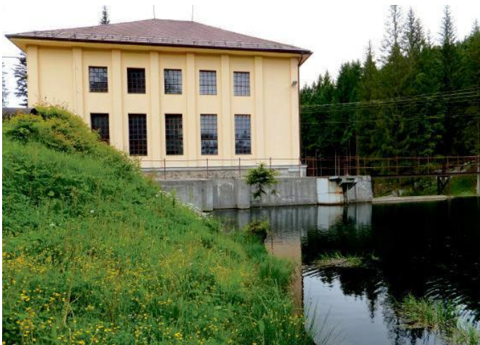
Přečerpávací elektrárna Brčálník.
