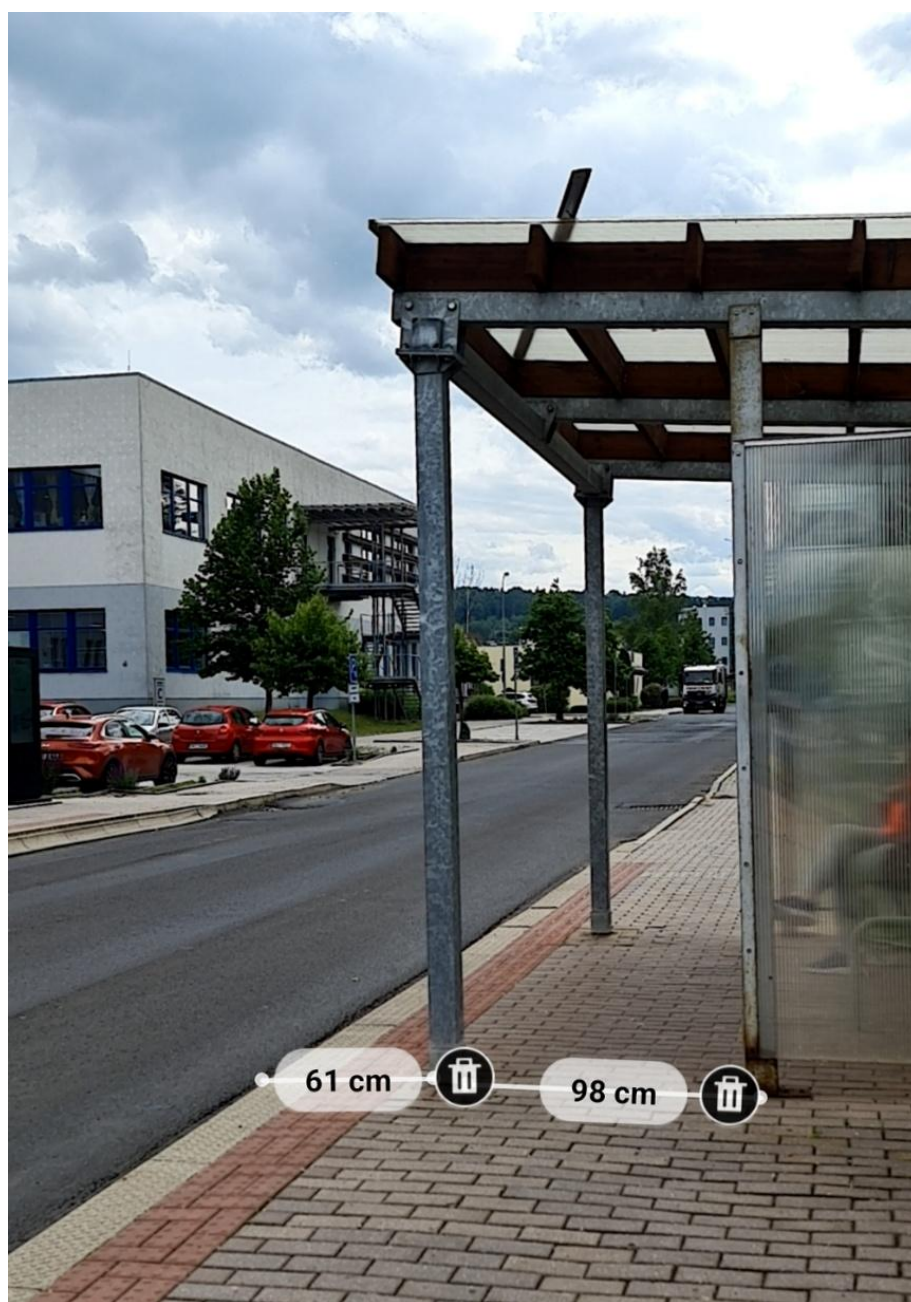
Obrázek 17: Konstrukce přístřešku příliš blízko k nástupní hraně
