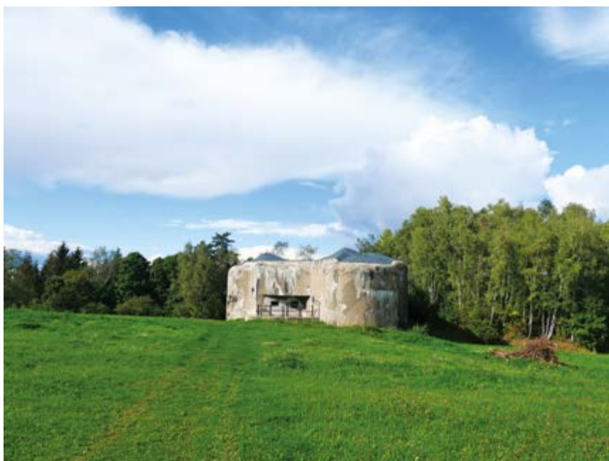
14. Pěchotní srub Jeřáb (N-S 73 Jeřáb), Dobrošov (Královhradecký kraj), 2022, z archivu Památkové inspekce
