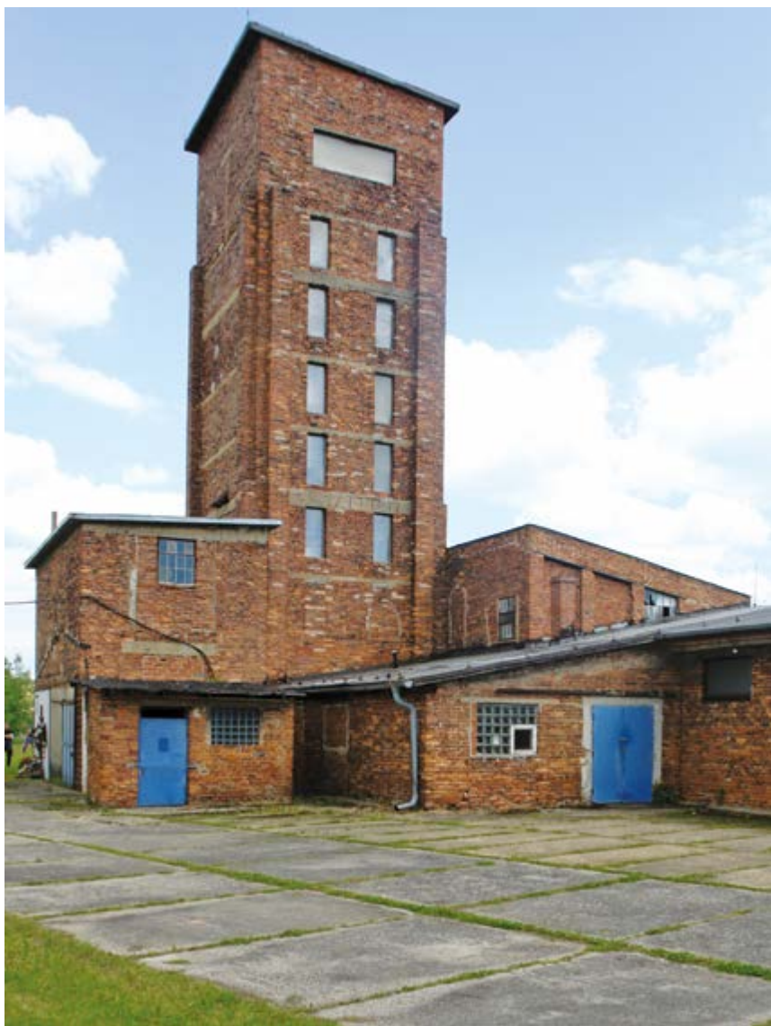
23. Třídírna uranové rudy tzv. Rudá věž smrti v Ostrově (Karlovarský kraj), 2021, z archivu Památkové inspekce
