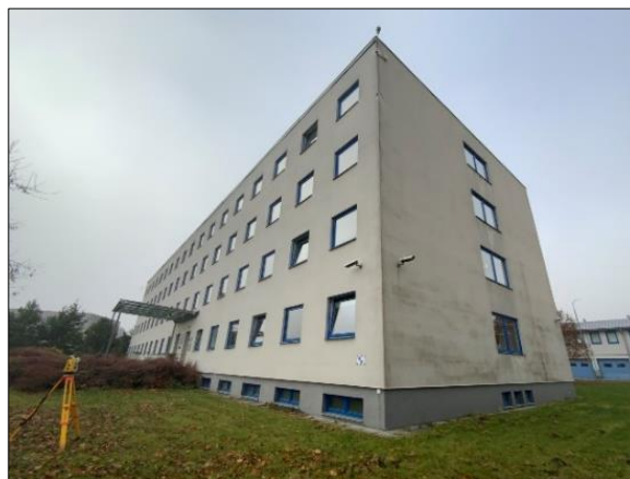
Budova B z úrovně terénu
