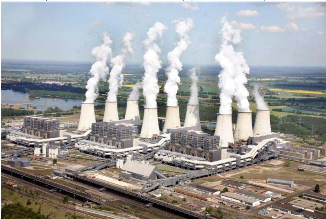
Obrázek 8.4: Tepelná elektrárna Jämschalde (400.000 t/rok RDF, 6 jednotek o 500 MW každá)
