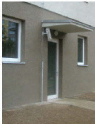
Kamera u zadního vchodu do objektu
