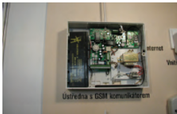
Ústředna EZS s GSM komunikátorem
