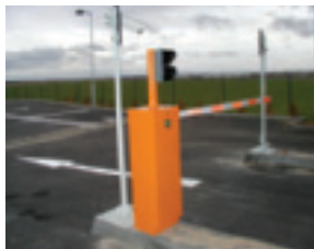
Vjezd na hlídané a zabezpečené parkoviště
