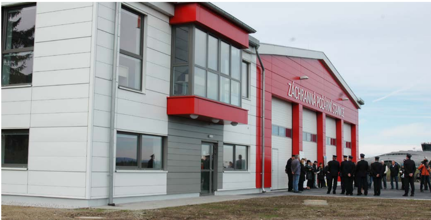
Nová požární stanice Namísto starého dosluhujícího objektu budou teď hasiči na karlovarském letišti využívat moderní zázemí východně od terminálu letiště, tedy v ideální poloze vůči vzletové a přistávací dráze. Foto: KÚ
