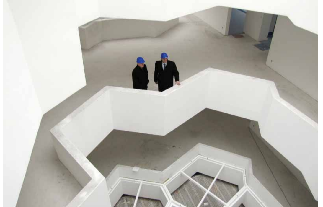
Ředitel školy Pavel Janus (vlevo) a hejtman Josef Novotný si během kontrolního dne prohlédli rozestavěné prostory školy. Systémem skeletu žádná taková stavba v republice není, architektonicky půjde o unikátní školní budovu, dozvěděli se na místě novináři.
