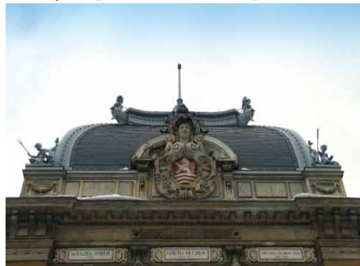
Opravená kopule Císařských lázní. Památkově chráněný objekt se nyní připravuje na rozsáhlou rekonstrukci. Foto Václav Fikar
