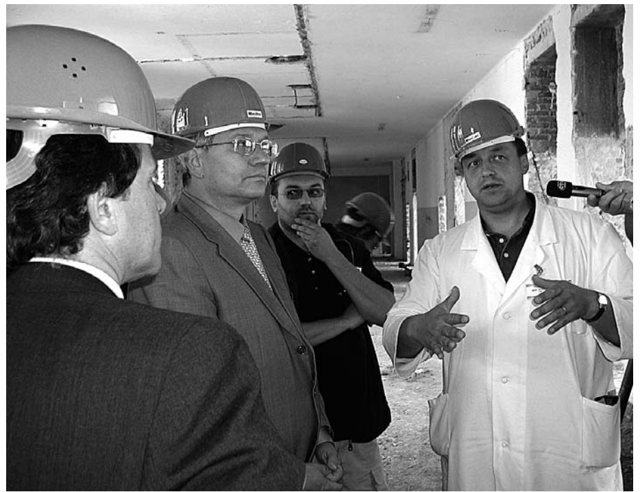
Jak pokračuje druhá etapa rekonstrukce karlovarské nemocnice zjišťoval při kontrolním dnu hejtmán Karlovarského kraje Josef Pavel (druhý zleva). S jejím průběhem ho seznámil ředitel nemocnice Jiří Štefan (v bílém plášti).
