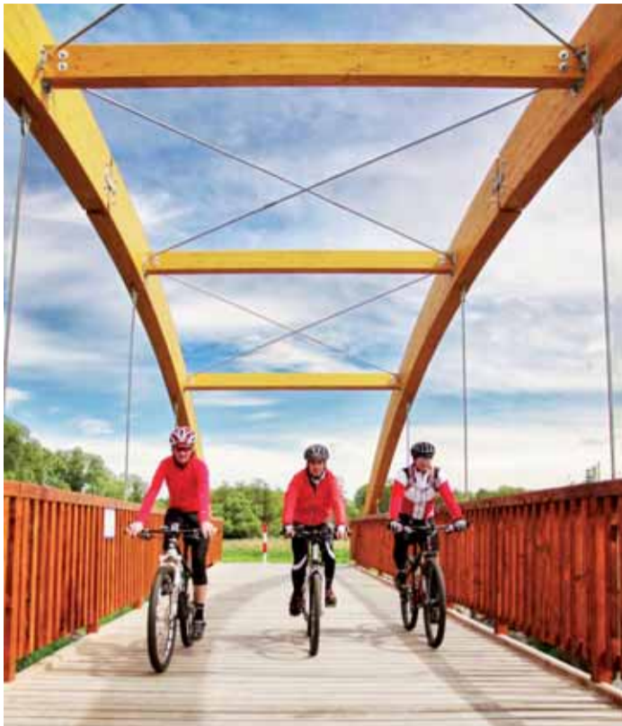
Nová lávka přes řeku Ohři v chebské části Hradiště. Foto Václav Fikar
