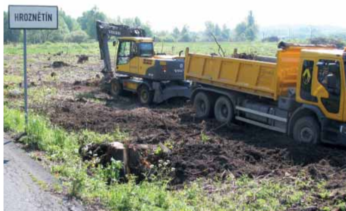
Stavba obchvatu Hroznětína.
