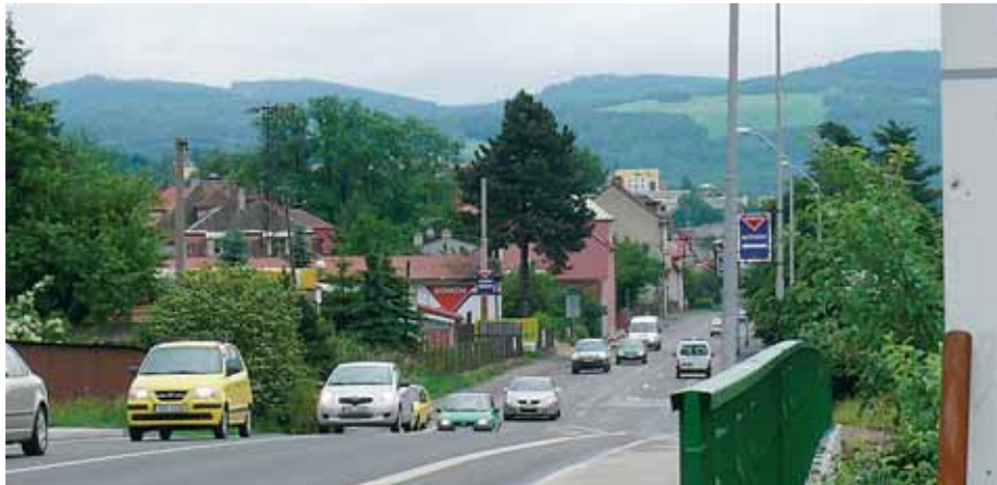
Konec letošního května znamenal také konec rozsáhlé rekonstrukce tří navazujících mostů v Sokolově. Po dvou letech oprav je Sokolov směrem na Svatavu a Kraslice opět hladce průjezdný. Foto archiv
