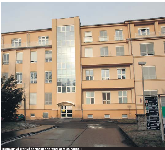
Karlovarská krajská nemocnice se vrací opět do normálu.
