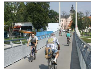
České Budějovice: nový most pro pěší a cyklisty vede přes dopravní komunikaci a řeku k nákupnímu středisku
