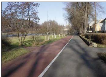
Úsek Labské stezky v Ústí nad Labem: cyklistické stezky jsou navrženy i ze záměrem, aby je mohli využívat také bruslaři a vozíčkáři
