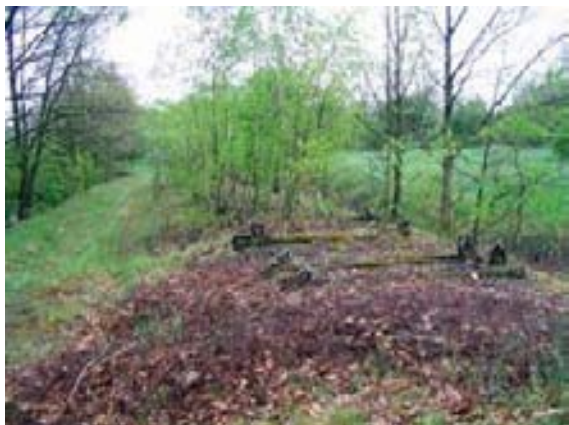
Drážní těleso před úpravou (Háje)
