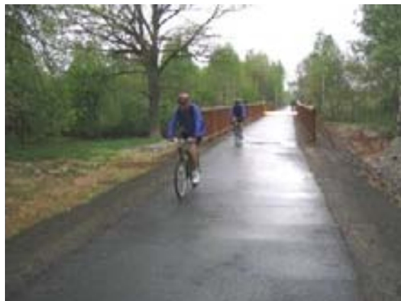
Drážní těleso po úpravě (Slapany)
