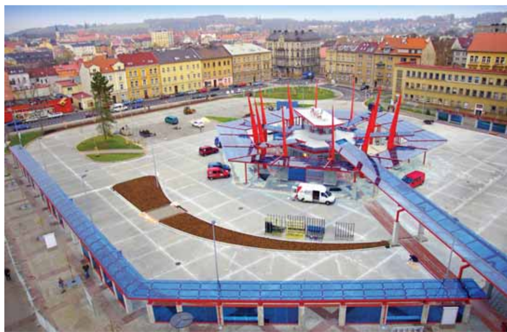
Nový dopravní terminál v Chebu
