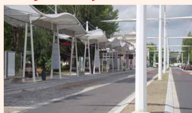
Nahore nový dopravní terminál v Mariánských Lázních, dole rozeztavěný dopravní terminál v Chebu. Foto Václav Fikar
