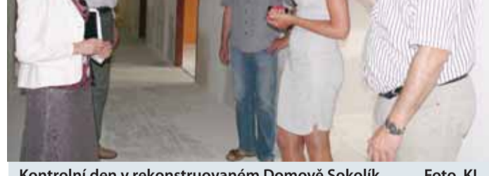
Kontrolní den v rekonstruovaném Domově Sokolík. Foto KL
