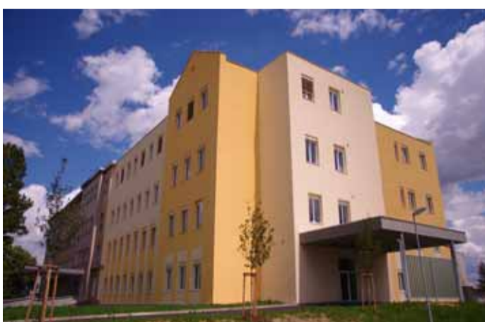
Pravá část pavilonu B chebské nemocnice, tedy hlavní budovy, prošla rekonstrukcí. V dalších etapách bude postupně zrekonstruována celá budova. Jak je z dokončené části zřejmé, nemocniční budova získává částečně podobu, jakou měla v době svého vystavění na začátku 20. století. Tehdy ji dobový tisk označoval za nejkrásnější nemocnici v zemi. Foto Václav Fikar
