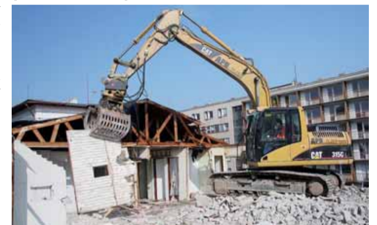
Stavba začala demolicí tří budov u hlavního vjezdu do nemocnice. Foto KL
