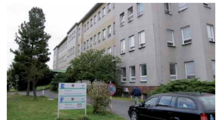
Chebská nemocnice se dočká rekonstrukce.
