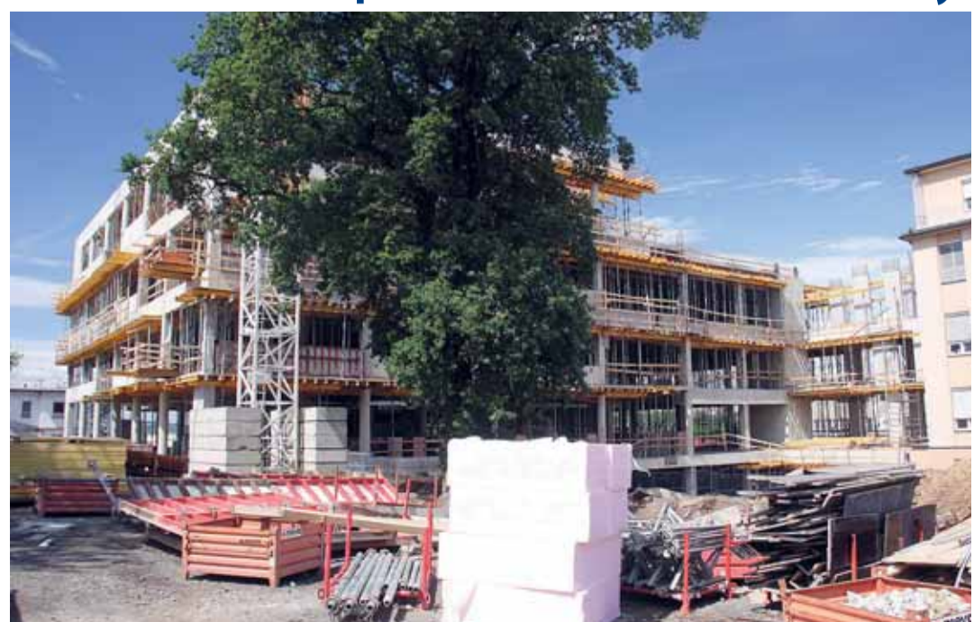
Stavba pavilonu už dosáhla konečné výšky. Foto KL
