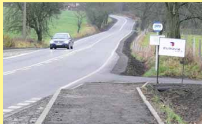
Modernizovaný úsek silnice Aš-Hranice.
