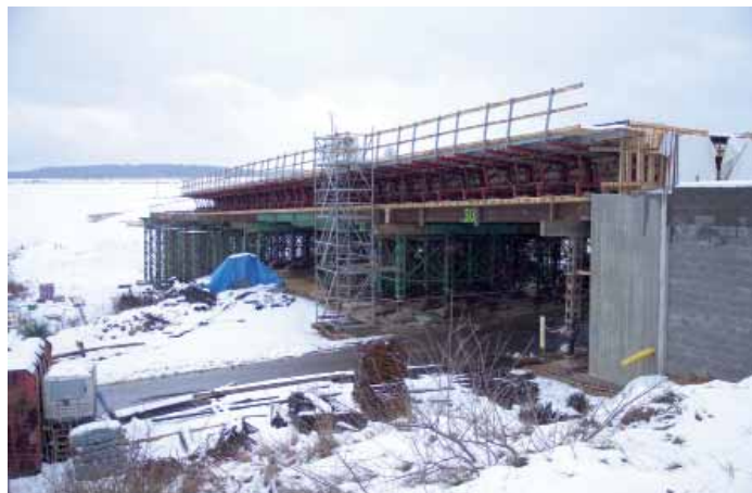
Rozestavěné nové mosty v Chebu. Vznikají na jihovýchodním obchvatu města - u Hájí. Pod silničním mostem na snímku vpravo, který směřuje do lokality Švédský Vrch, vede trať Plzeň - Cheb.
