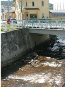
Zrekonstruovaný most na silnici II. třídy v Nejdku na Karlovarsku dokončili v termínu pracovníci firmy SMP CZ, a. s. Stavěbní práce, které trvaly více než devět měsíců, přišly na téměř čtyři a půl milionu korun.
