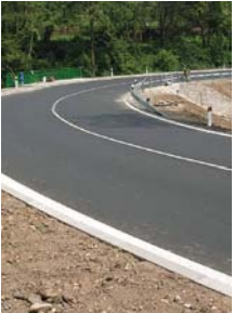
Více než 12 milionů korun stála oprava komunikace a mostu na vozovce II/220 před Nejdkem. V rámci stavby byla mimo jiné firmou Viamont DSP, a. s., provedena úprava nepříznivých směrových poměrů úseků silnice v délce zhruba 240 metrů.
