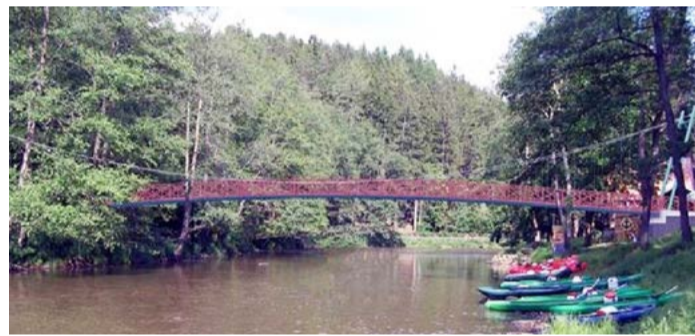
Nová lávka uleví stávajícímu dřevěnému mostu.
