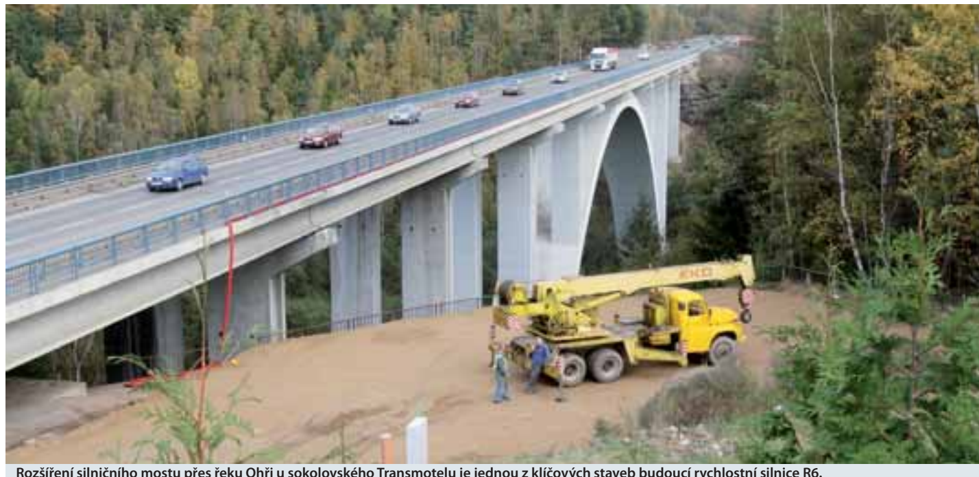
Rozšíření silničního mostu přes řeku Ohři u sokolovského Transmotelu je jednou z klíčových staveb budoucí rychlostní silnice R6.
