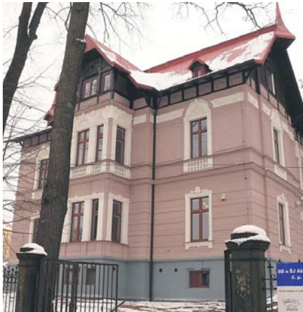
AŠ – Opravená budova Dětského domova v Aši, která byla dříve využívána jako léčebna dlouhodobě nemocných, nabízí dětem kvalitnější bydlení. Náklady na obnovu objektu přesáhly deset a čtvrt milionu korun.
