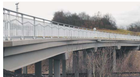
NEJDA – Rekonstrukci 56 metrů dlouhého mostu u obce Nejdá si vynutil jeho havarijní stav a zatékání do nosné konstrukce. Stavební práce trvaly od června do listopadu. Stavbaři museli odstranit původní vrstvy vozovky, porušenou izolaci a demontovat římsy mostu i zábradlí. Komplikovaná oprava přišla kraj na více než osm milionů korun.
