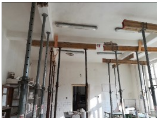
Podstojkování železobetonových stropů
